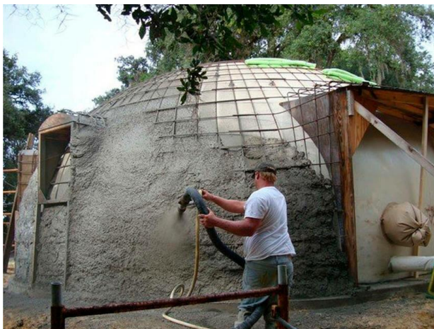
Рисунок 5 – «Распыление цементной смеси спецоборудованием»
