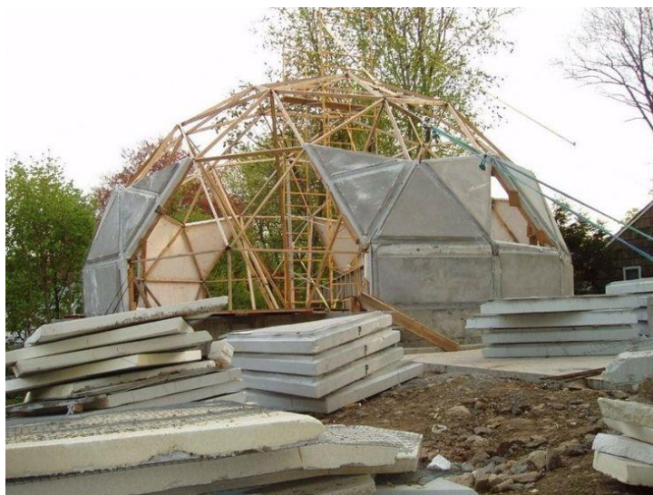
Рисунок 7 – «Сборка купольного дома из заводских блоков»
