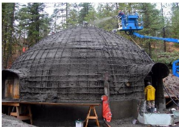
Рисунок 4 – «Пневмокаркасная технология»
