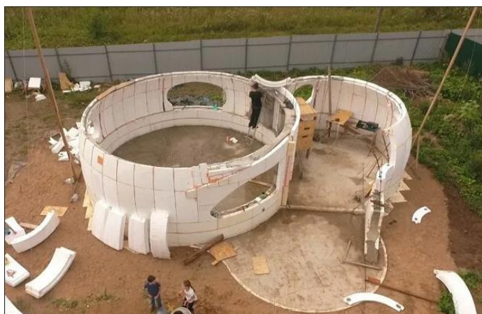
Рисунок 6 – «Несъемная опалубка»
