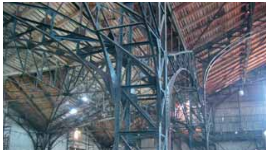
Стальные конструкции пакугаузов на Стрелке, 2017 г.
